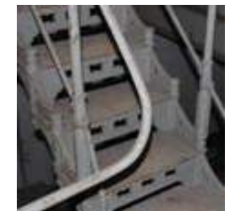
TREPPE AUS GUSSEISEN
