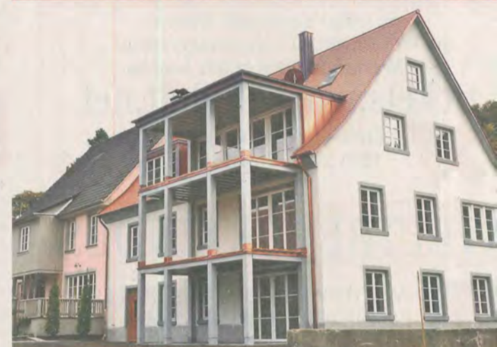
Im »Seeadler«, den viele als »Neuen Adler« kennen, entstanden nach dem Abriss drei neue Mietwohnungen.
