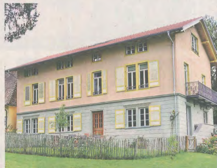
Nach der Restaurierung erstrahlt die Sommervilla am Seeufer wieder im alten Glanz.
